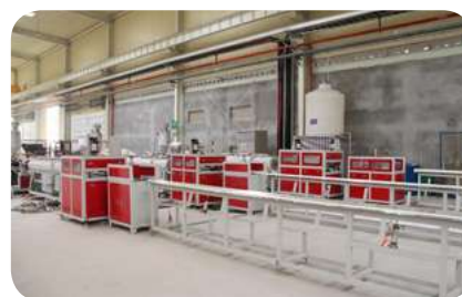
PE Pipe Line
